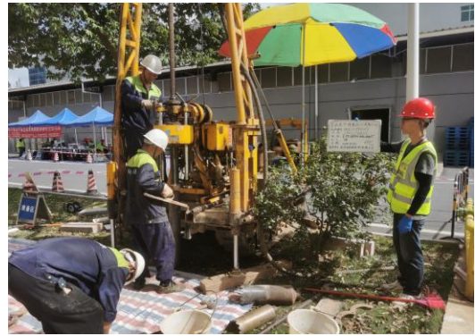
1A01-钻机类型、套管跟进
