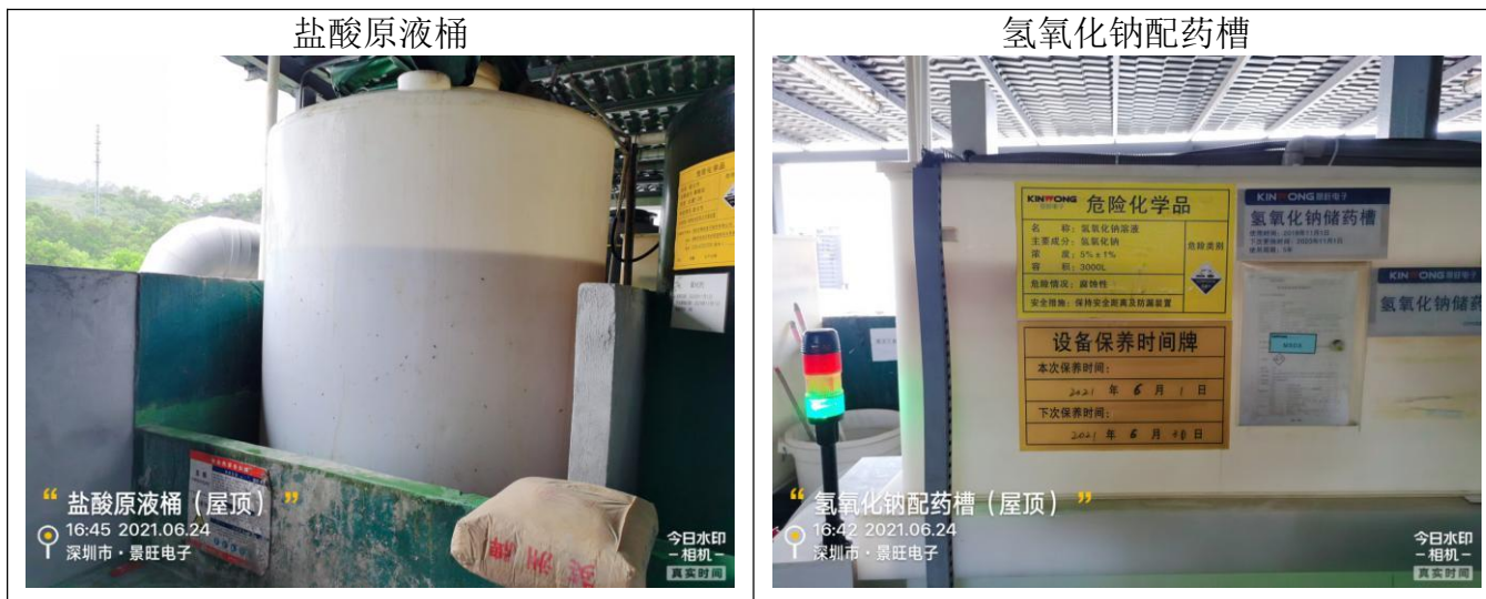
危险化学品储存现场照片（部分）
